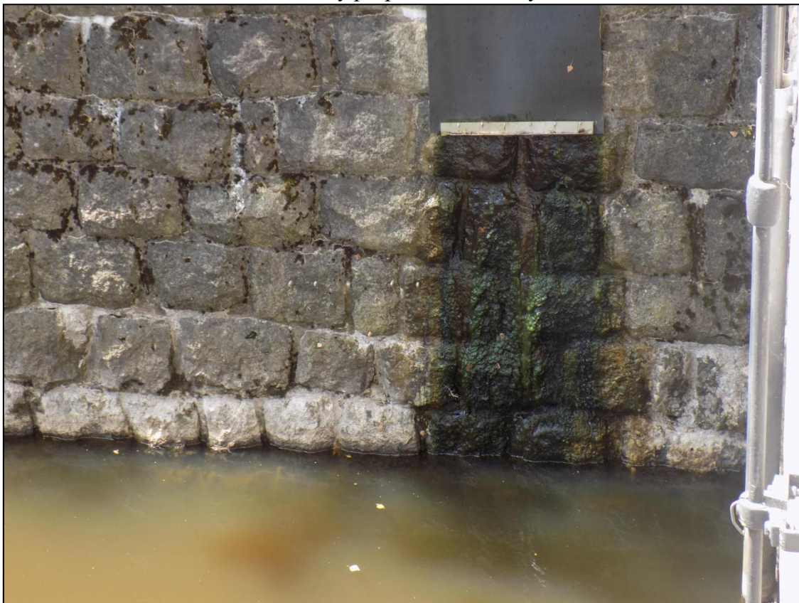
Detail dlažby při pravém břehu vývaru
