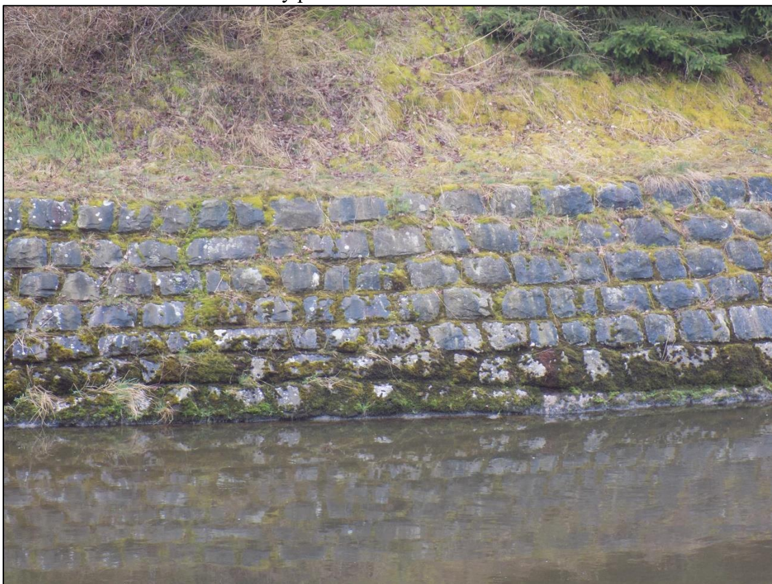
Detail dlažby při návodní straně dělicího ostrova
